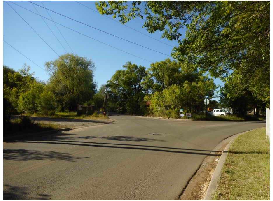
N. Facing South
