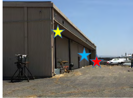
Hangar Doors, Hangar B
