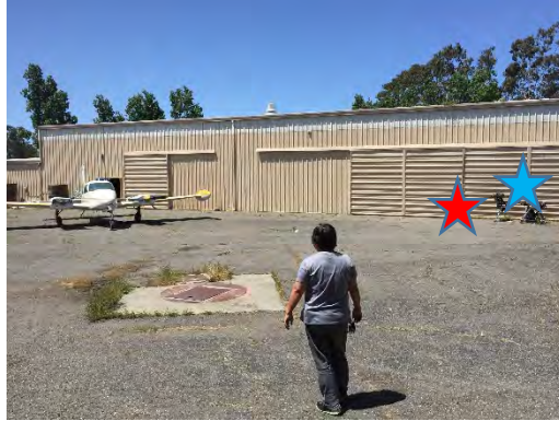
Hangar Doors, Hangar A
