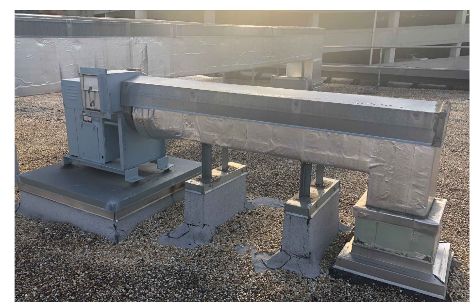
6 AD-102 NTS EXHAUST FAN (TYP)
