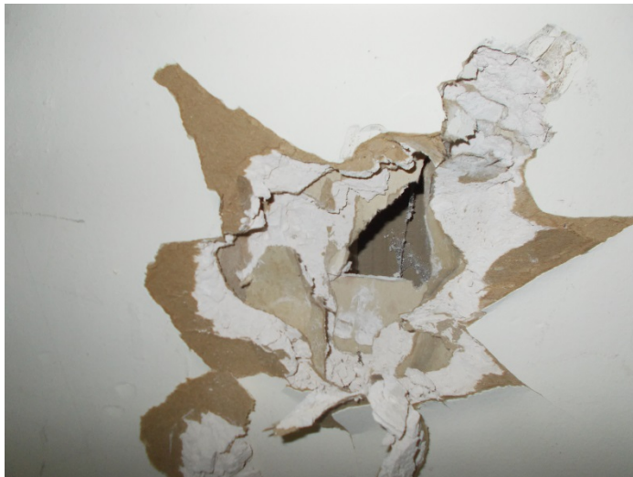
Photo 13 – Double layer drywall
