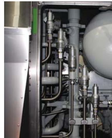
*Figure 25. Pressure Relief Valves*
