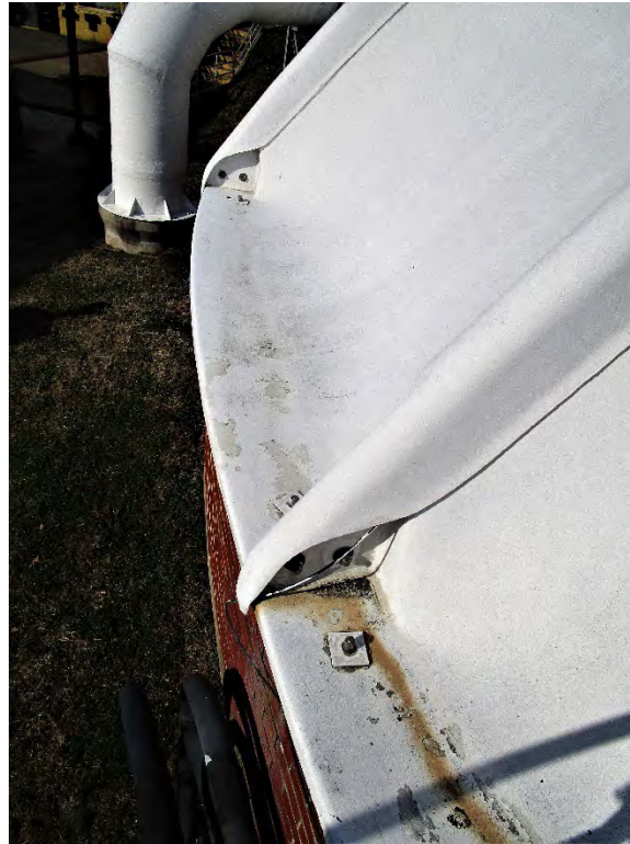
Photo A-11. Dome Anchorage
